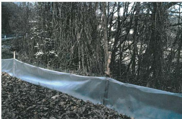
zato è stato possibile sistemare le barriere temporanee all'inizio della migrazione produttiva. Le barriere della lunghezza di poco meno di 200 metri, sono state poste sul lato a monte della strada, in modo da sfruttare i sottopassi esistenti. Anche se non è possibile farlo aderire perfettamente al terreno, il telo di polietilene
